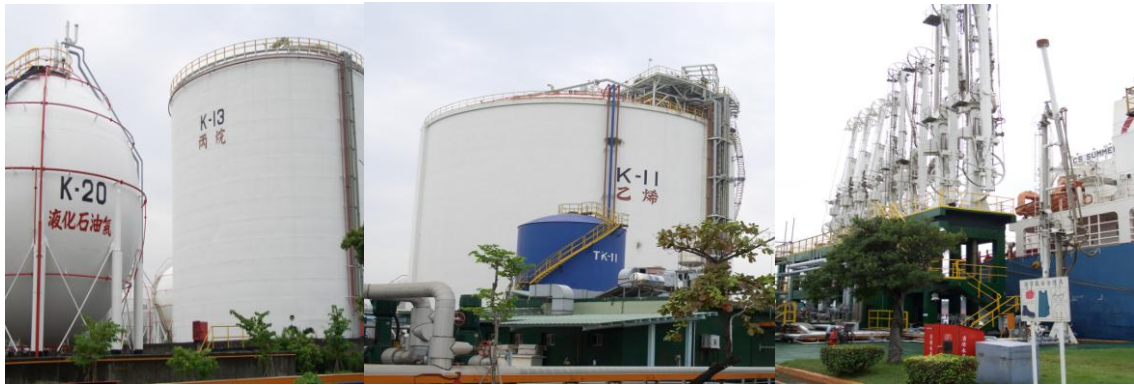
圖 2.12 LPG 高壓槽/LPG 槽(常壓低溫) 乙烯槽(常壓低溫) LOADING ARM 裝卸貨臂 資料來源：本文拍攝
